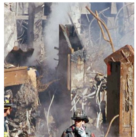
Effet d'une charge de découpe vu sur le site du WTC (la découpe a pu être l'œuvre de l'équipe de déblaiement)
